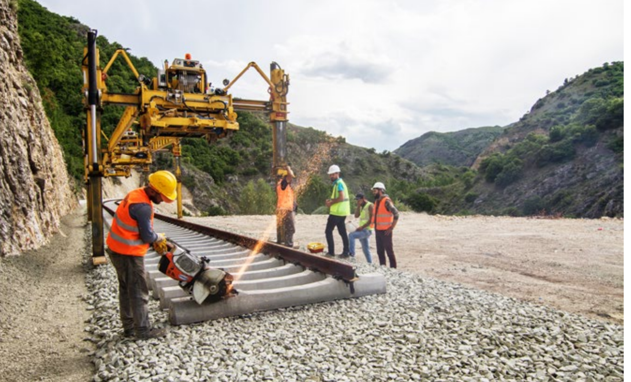
SAMSUN-KALIN DEMİRYOLU HATTI'NİN MODERNİZASYONU PROJESİ MODERNIZATION PROJECT OF SAMSUN-KALIN RAILWAY LINE
