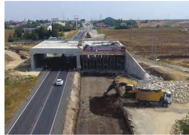
Halkalı Kapıkule Demiryolu Projesi-Halkalı Kapıkule Rail Line Project
